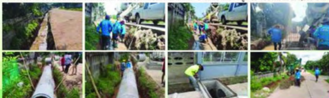
โครงการวางท่อระบายน้ำคอนกรีตเสริมเหล็ก พร้อมบ่อพักคอนกรีตเสริมเหล็ก บ้านต้นป่าเหียง หมู่ที่ 13 งบประมาณ 298,500 บาท
