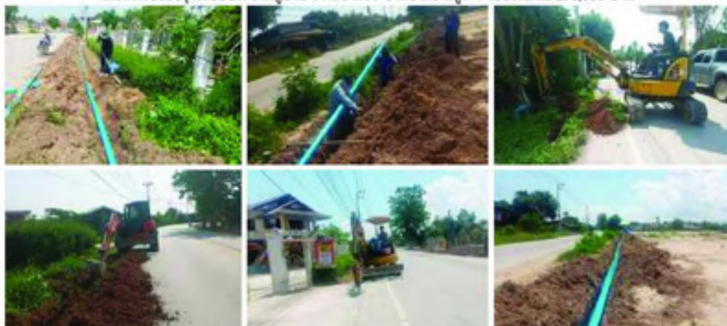
โครงการวางท่อระบายน้ำคอนกรีตเสริมเหล็ก พร้อมบ่อพักคอนกรีตเสริมเหล็ก บ้านต้นป่าเหียง หมู่ที่ 13 งบประมาณ 298,500 บาท
